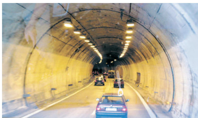
Neue Technologien ermöglichen schnelleren Tunnelbau und längere Haltbarkeit der Bauwerke. Foto: Bilderbox.com
