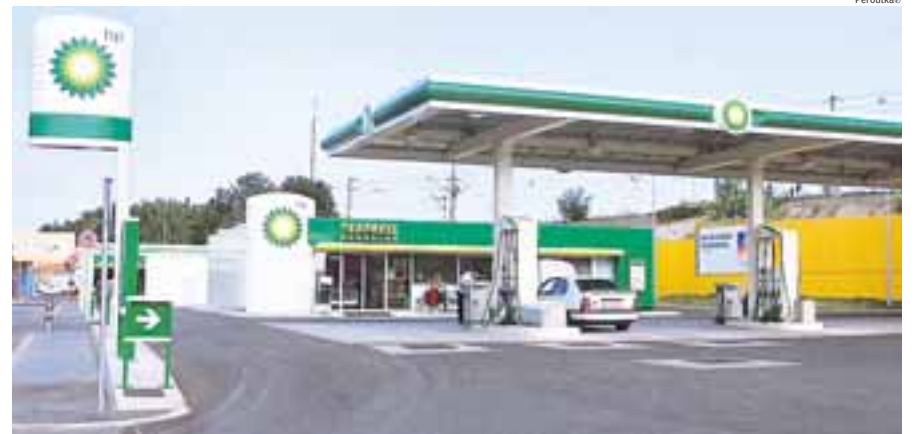
Bei BP Austria kommt es nicht nur auf beste Mineralöl-Leitungen an, auch die Telekommunikation muss passen – dafür sorgt nun T-Systems
