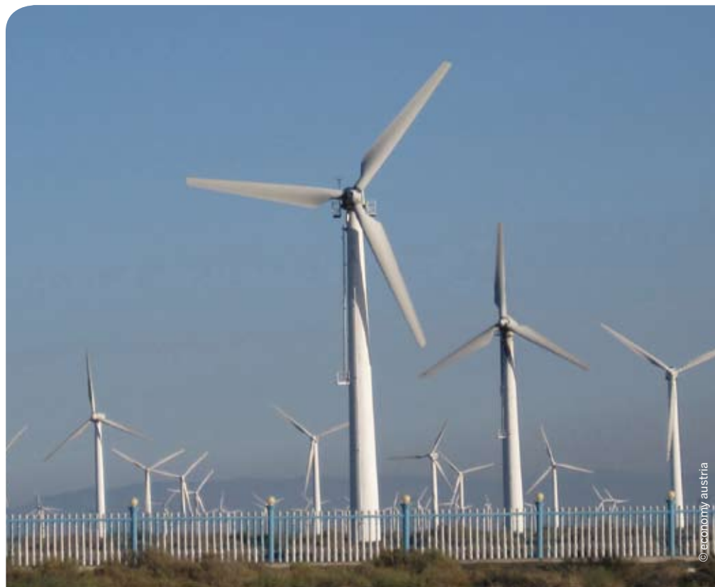
Innovative IKT-Lösungen tragen auch zu einer effizienten, nachhaltigen Energieversorgung bei.
