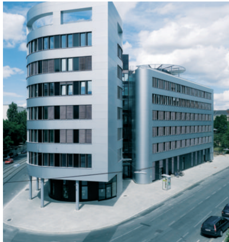
14 Mio. Euro wurden in das neue „Haus der Forschung“ Ecke Spitalgasse/Sensengasse in Wien investiert. Foto: BIG/Bruno Klomfar
